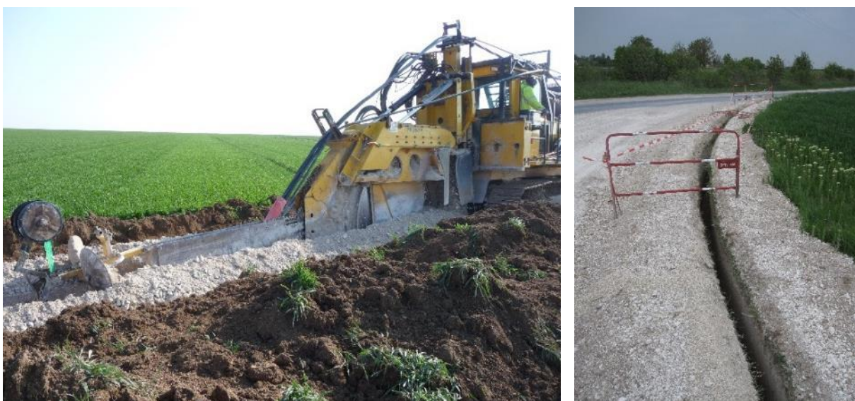
Figure 4. Exemple de tranchée réalisée (Source : Total Solar)
